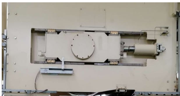
图8 某企业连续压机钢带张紧液压系统
